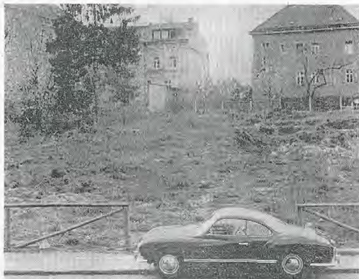
Wo jetzt noch ödes Gelände ist, soll in der Nähe des Fünferl-Stegs noch heuer der Rohbau des Finanzamts und des Gesundheitsamts fertig werden. Das Gebäude wird über drei Millionen DM kosten (Foto: Schlosser)
