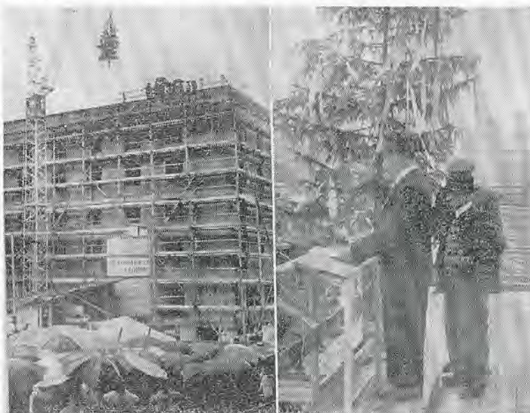
Ein Kran hievte den Richtbaum auf den Finanzamtsneubau, dessen Richtfest gestern gefeiert wurde. (Foto: Schlosser)
